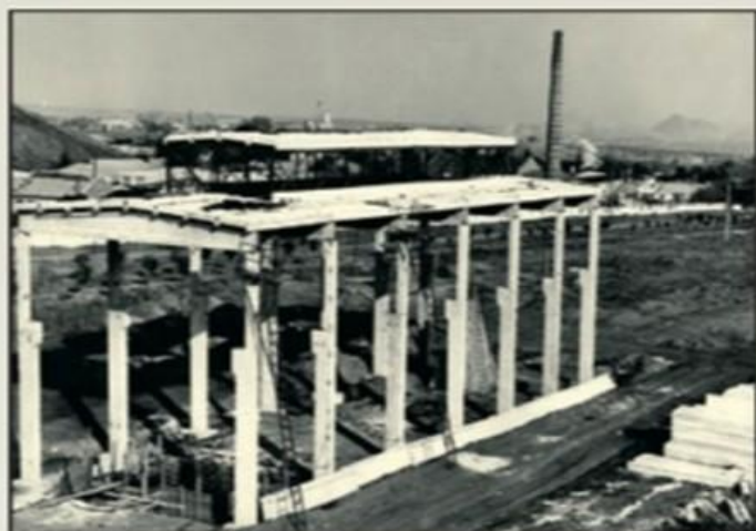
Строительство машиностроительного завода в Первомайске
