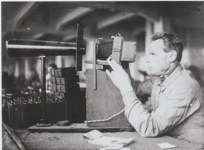
Юстировка объектива камеры Фотокор, около 1931–1932 гг.
