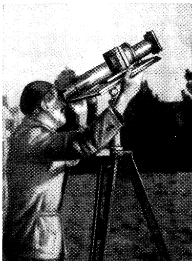
Рис. 13. Простая монтировка короткофокусной камеры для фотографирования зодиакального света на азимутальном штативе с гидрирующей трубкой без оптики.
