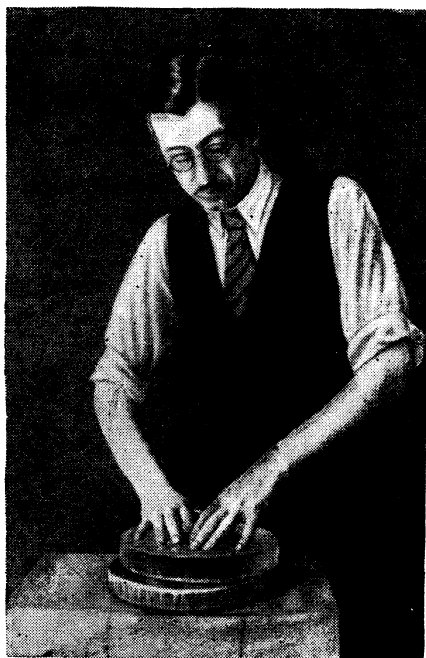
Рис. 40. Шлифовку зеркала диаметром 26 см проводит Б. А. Воронцов-Вельяминов (1940 г.).
